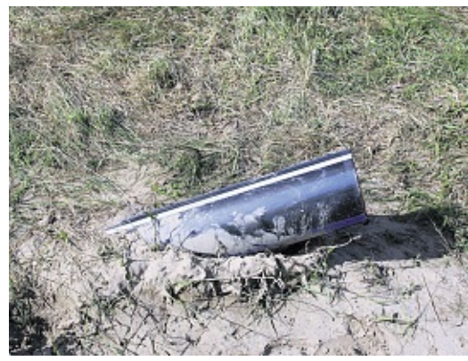
So sieht es aus, das neue Polyethylenrohr für die Trinkwasserversorgung von Neuwerk. Bis zu 100 Kubikmeter werden dort in der Hochsaison benötigt.
